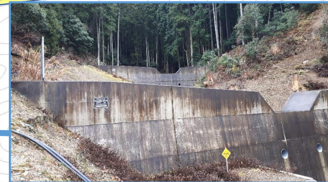
堰 堤（２段構えに設置）
