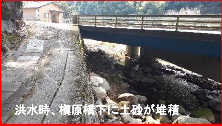
洪水時、横原橋下に土砂が堆積
